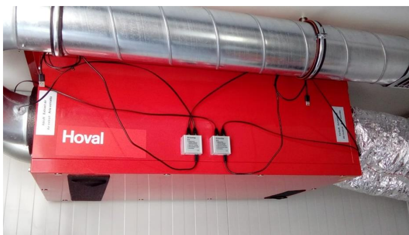
Slika 5.1 - SEK – SensorBridge spojen na osjetnike [13]
