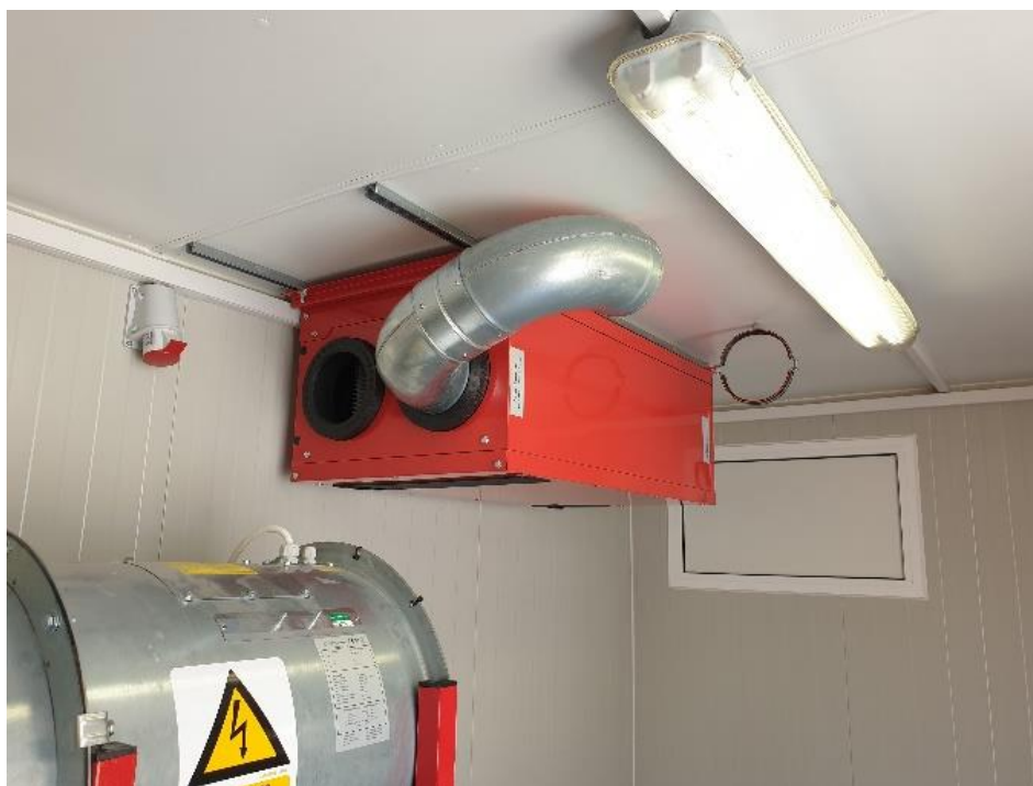
Slika 4.5 - Postavljanje nosača kanala [13]
