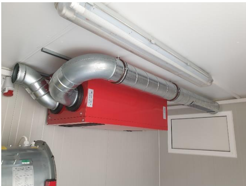
Slika 4.6 - Postavljen odvodni kanal [13]
