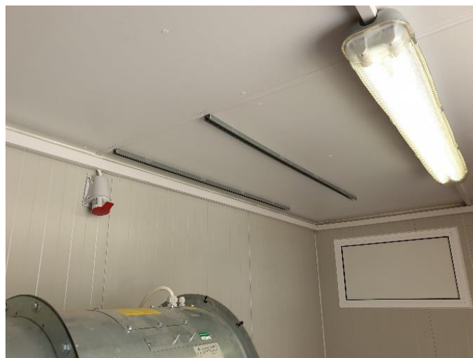
Slika 4.2 - Montaža pomoćnih profila [13]
