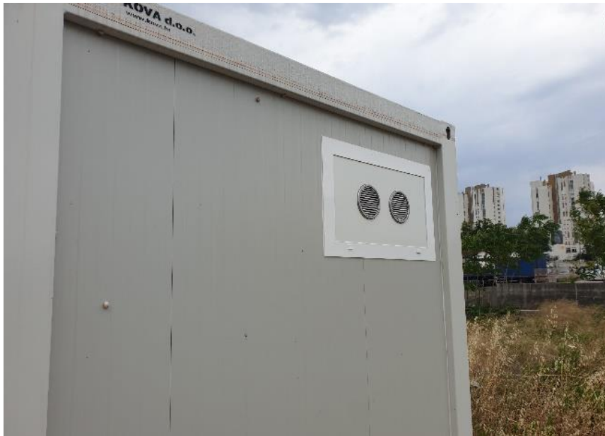
Slika 4.12 - Protu-kišne rešetke NVM 150 izvana [13]
