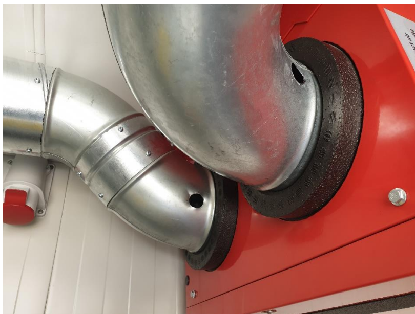
Slika 4.15 - Izbušeni otvori za osjetnike [13]
