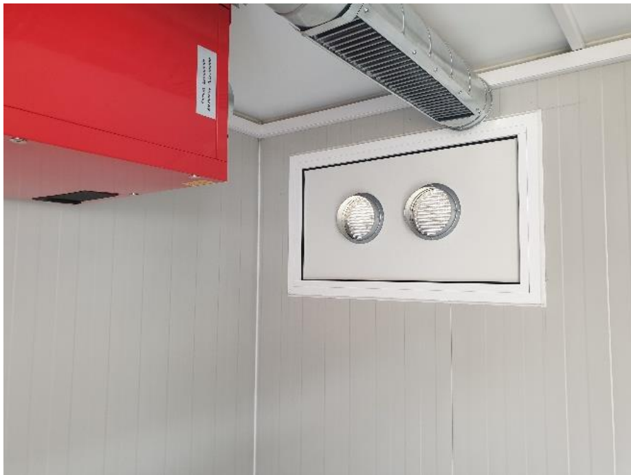
Slika 4.11 - Protu-kišne rešetke NVM 150 iznutra [13]
