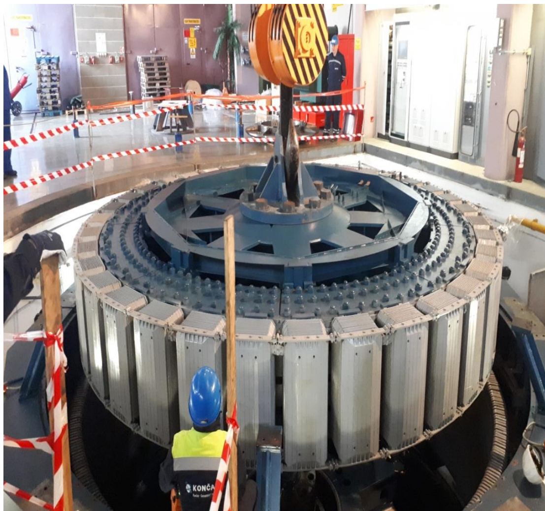
Slika 4. 14. Podizanje rotora [15]
