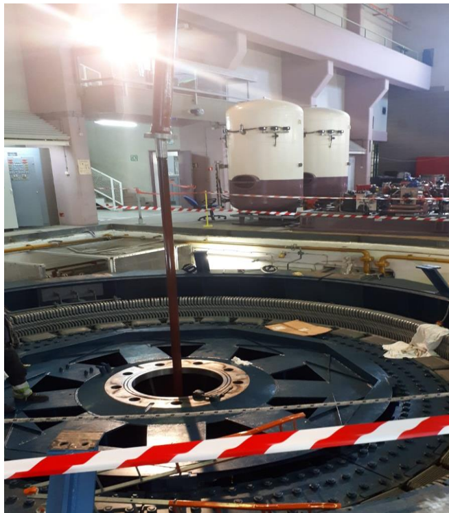
Slika 4. 10. Cijevi u vratilu [15]
