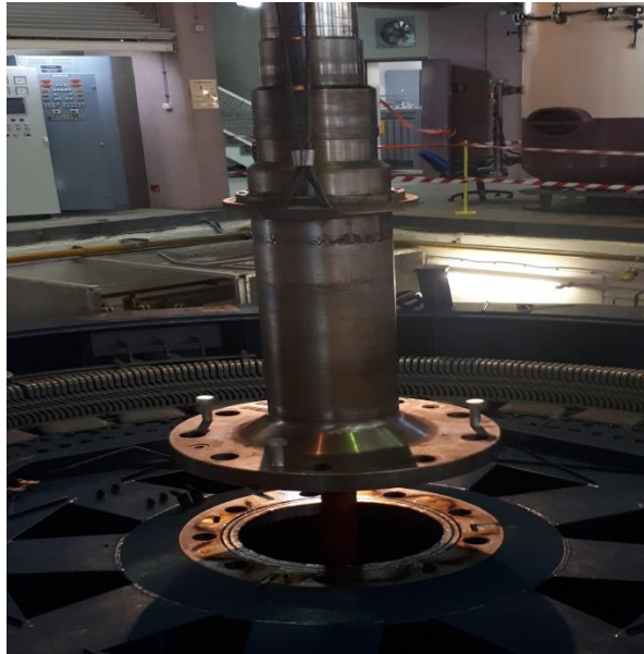
Slika 4. 9. Osovinski nastavak [15]
