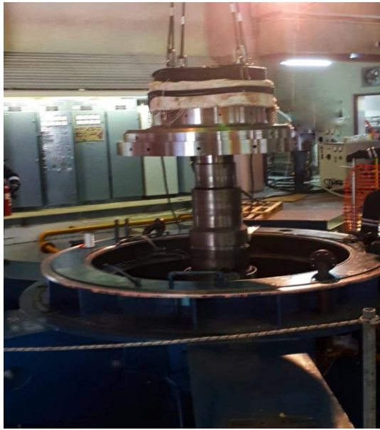
Slika 4. 6. Podizanje zvona generatora [15]
