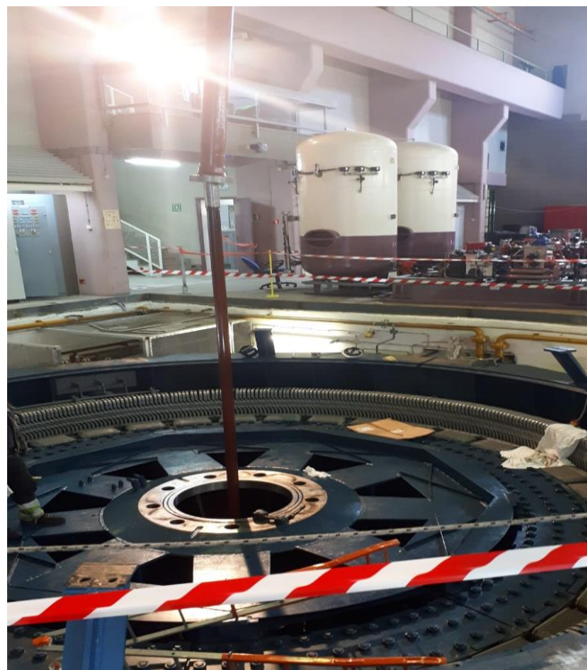
Slika 4. 10. Cijevi u vratilu [15]
