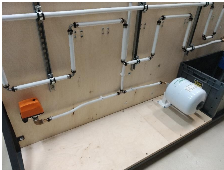
Slika 5.38 - Presostat i rastezna posuda
