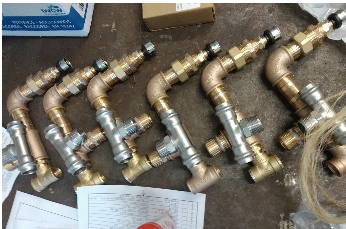
Slika 5.26 - Priprema sklopa prijelaza cjevovoda kroz ploču
