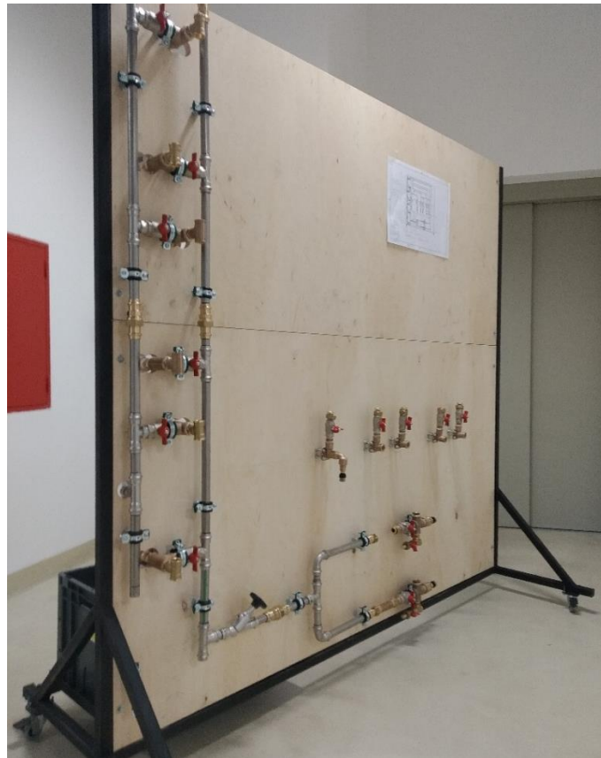
Slika 5.34 - Montaža elemenata, cijevi i obujmica
