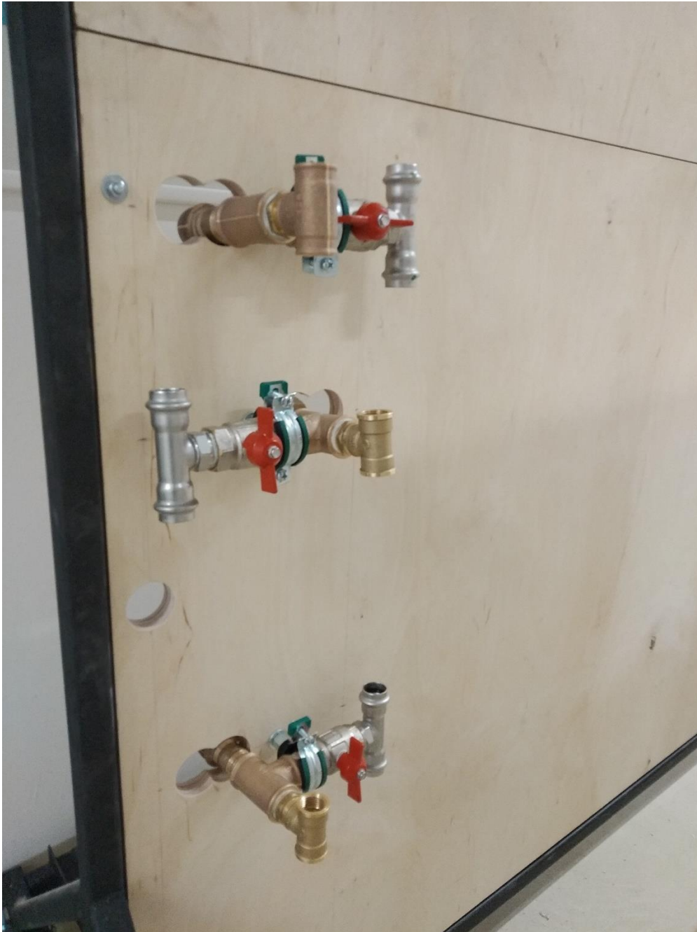
Slika 5.33 - Početna montaža elemenata i obujmica
