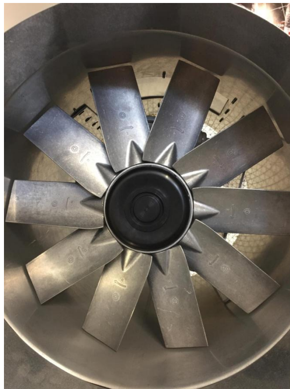
Slika 3.2.- Fotografija aksijalnog ventilatora AXC 500-10/21°-2
