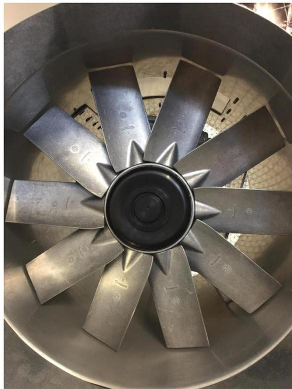
Slika 3.2.- Fotografija aksijalnog ventilatora AXC 500-10/21°-2
