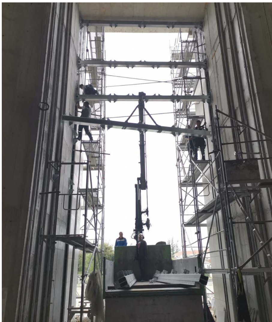
Slika 7.14- Montaža glavnih horizontalnih nosača
