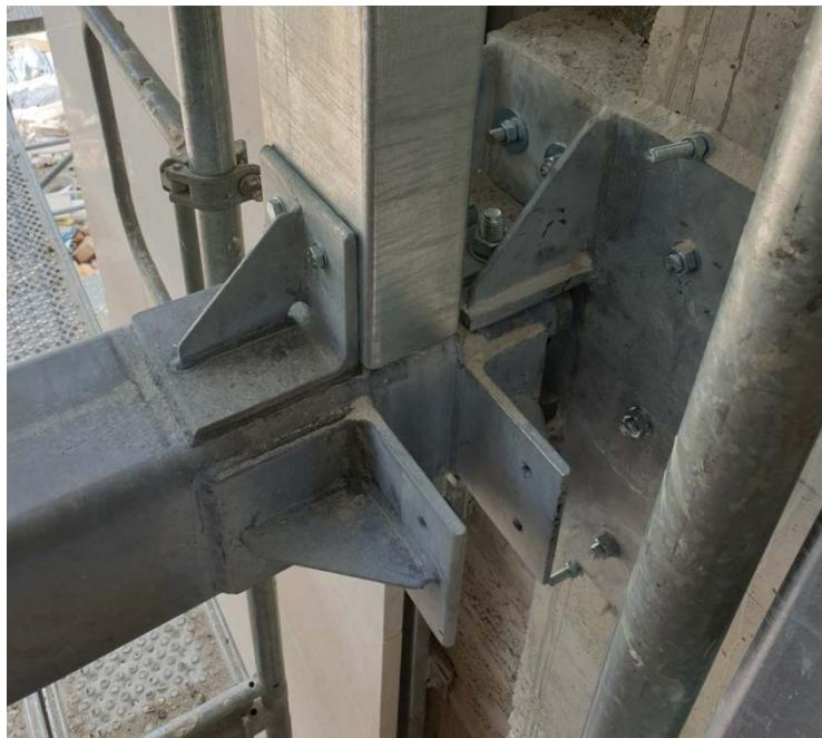
Slika 7.13 - Spoj vertikalnog i horizontalnog nosača
