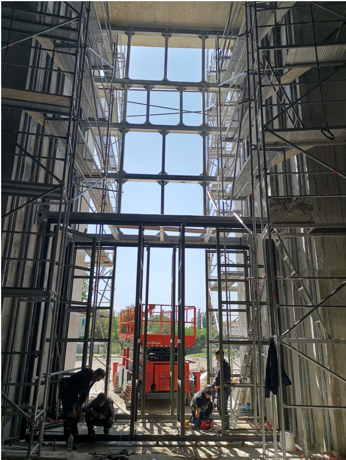
Slika 7.17 - Završena nosiva konstrukcija portala bazilike
