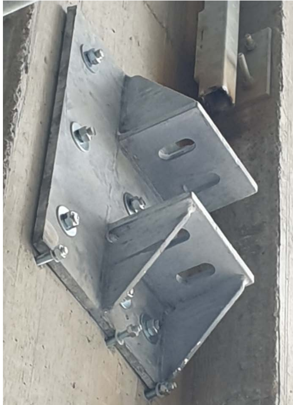
Slika 7.12 - Pokretni oslonac glavnog nosača pričvršćen za AB plohu
