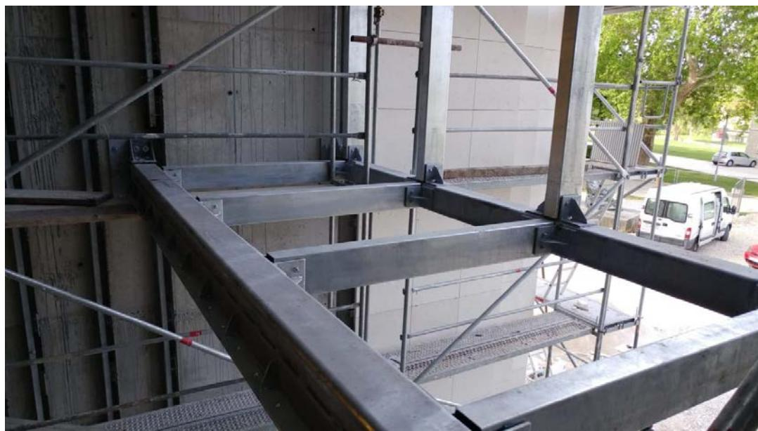
Slika 7.16 - Spoj glavnih horizontalnih nosača 1 i 0 u horizontalnoj ravnini
