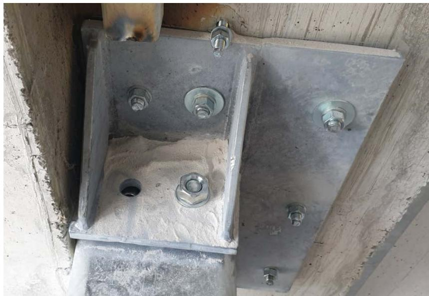
Slika 7.11 - Fiksni oslonac glavnog nosača pričvršćen za AB plohu
