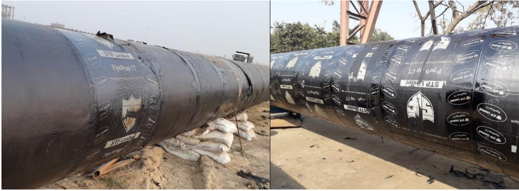
Slika 5.5 Primjer premaza na bazi katrana [26]
