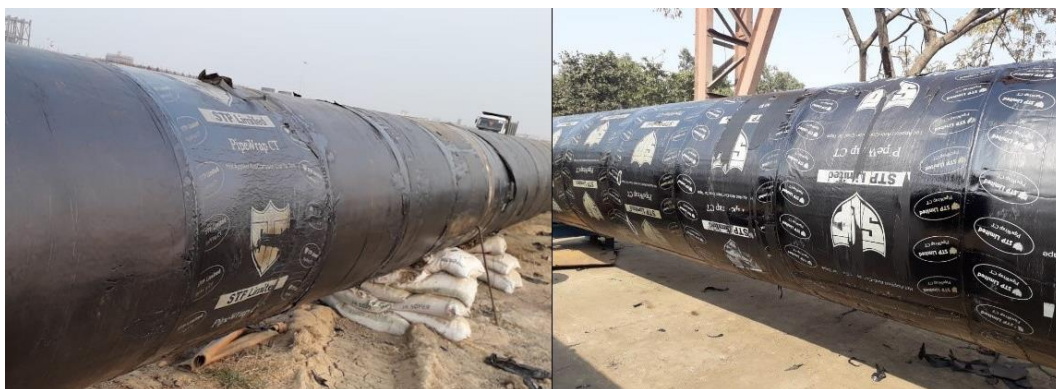
Slika 5.5 Primjer premaza na bazi katrana [26]
