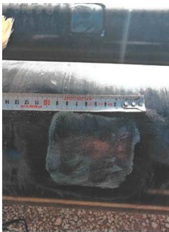
Slika 7.5 Pobrušeni dio izolacije za potrebe mjerenja debljine stijenke [44]
