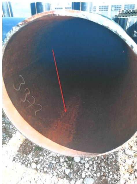
Slika 7.4 Površinski tragovi opće korozije unutar cijevi [44]
