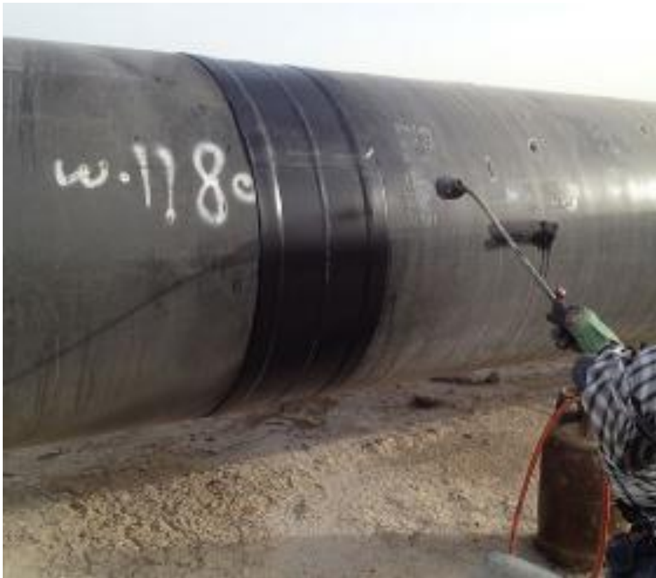
Slika 5.17 Nanošenje skupljajućih prevlaka [37]
