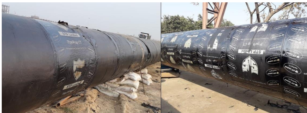
Slika 5.5 Primjer premaza na bazi katrana [26]
