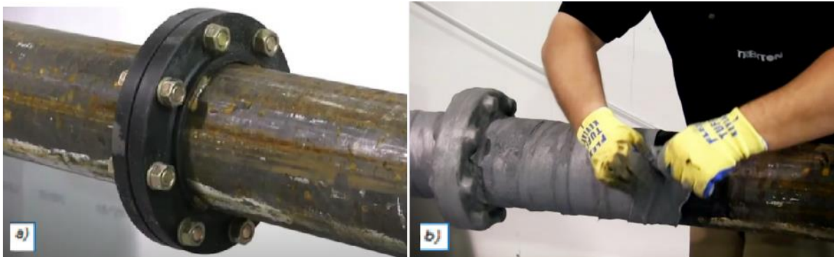
Slika 5.16 Postupak nanošenja prevlake na bazi voska; a) Prirubnica prije nanošenja presvlake; b) Prirubnica poslije nanošenja prevlake; [33]
