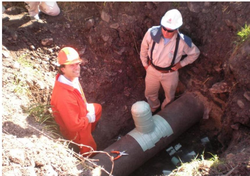
*Slika 5.14 Nanošenje vanjskog sloja visokoelastičnih obloga na T-spoj cjevovoda [32]*
