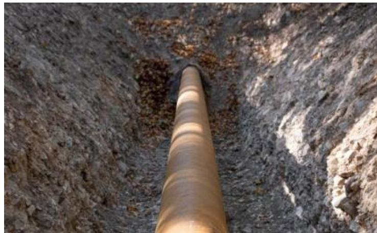
Slika 4.4 Opća korozija ukopane čelične cijevi [9]
