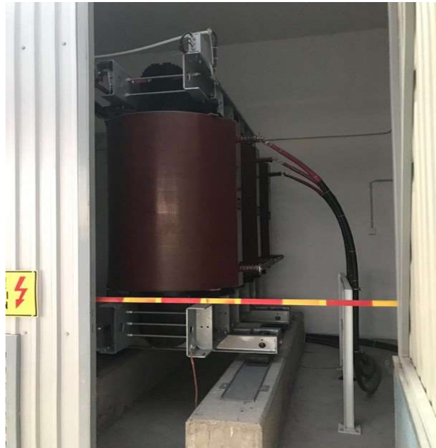
Slika 4.6. Transformator
