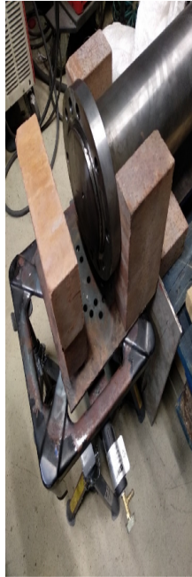
Slika 4.5- Izgradnja peći oko osovine i priubnice
