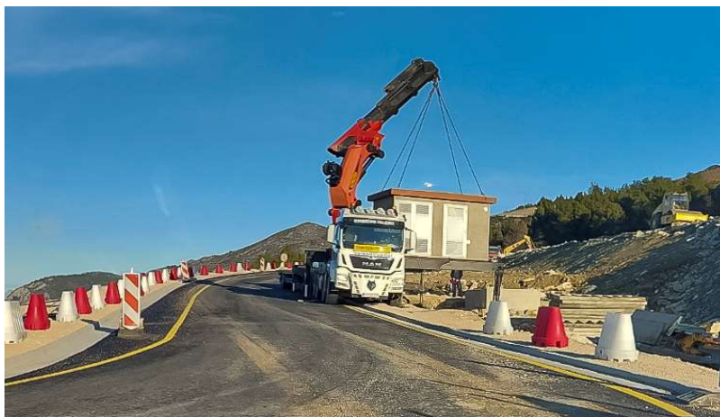
Slika 5.1. Montaža TS Duboka 10(20)/0,4 kV [37]
