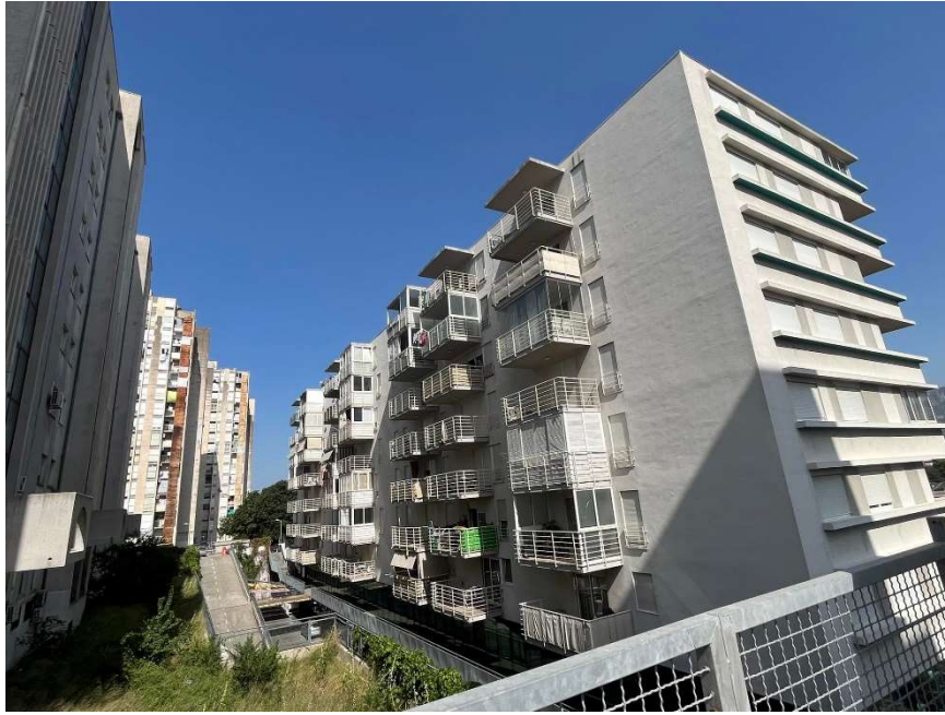
Slika 5.2. Južno pročelje višestambene zgrade [2]
