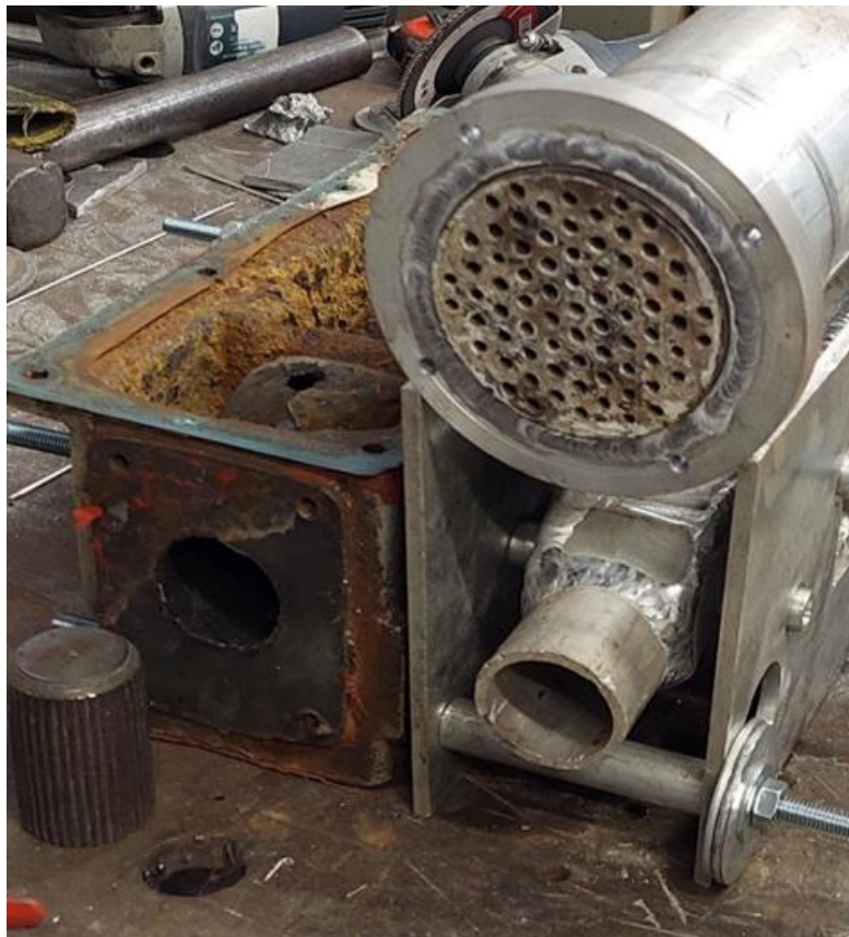
Slika 4.4 – Centriranje i priprema za zavarivanje [12]
