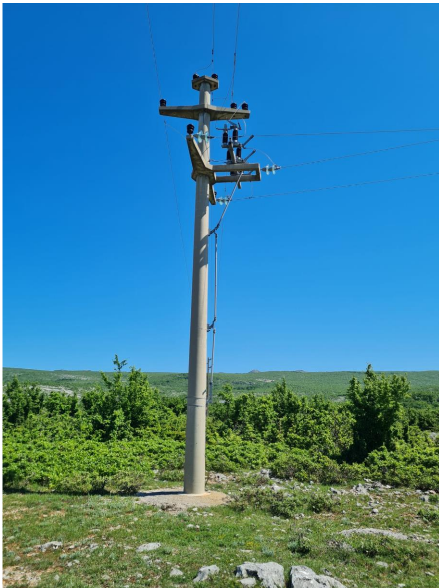
Slika 3.18. Stup bez ugrađenog DURN-a [TJ Sinj]
