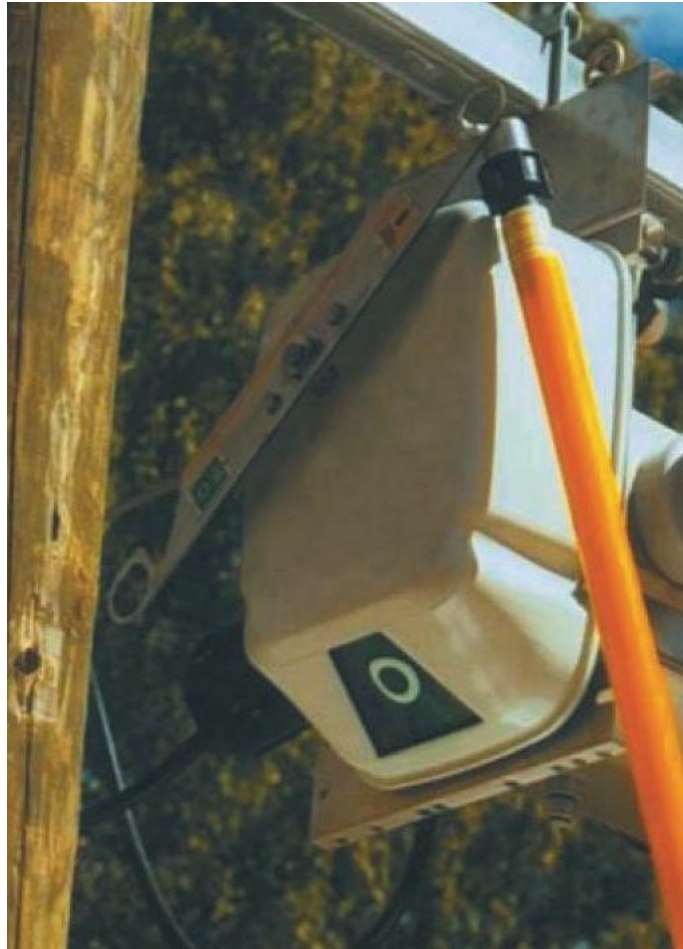
Slika 3.11. Mehanizam za manualno upravljanje izoliranom šipkom [3]
