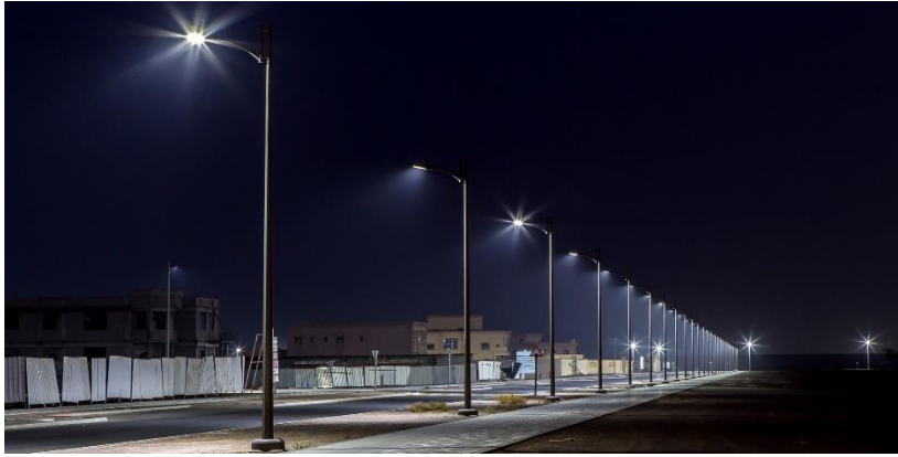
Slika 2.5. Primjer vanjske rasvjete - rasvjeta prometnice [9]
