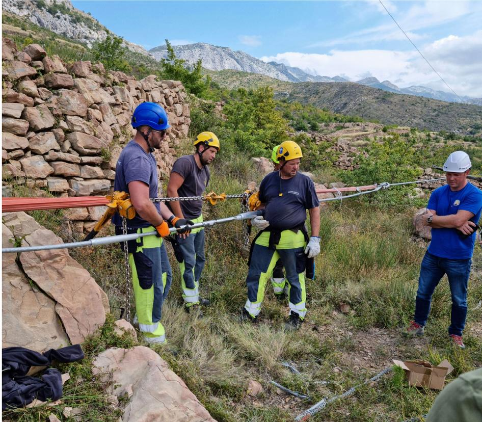
Slika 5.9. Izrada nastavne kompresijske spojnice vodiča
