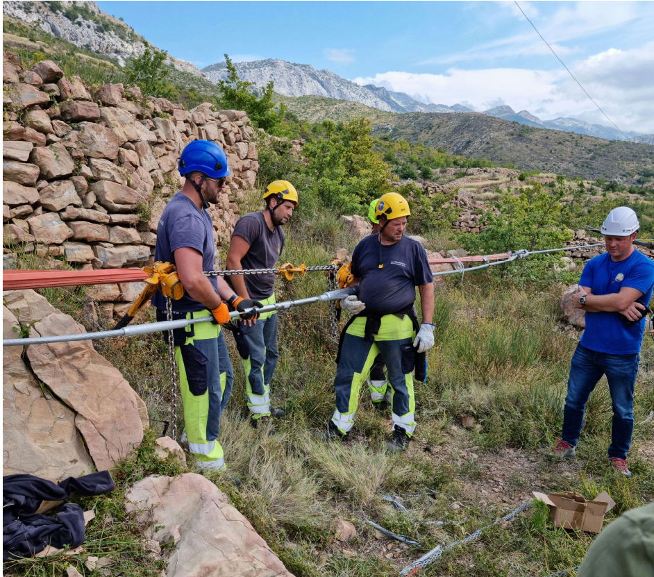
Slika 5.9. Izrada nastavne kompresijske spojnice vodiča
