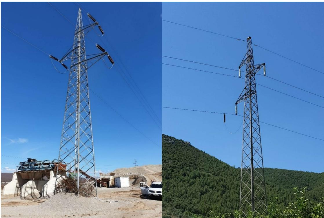
Slika 2.4. Zatezni i nosivi stup nadzemnog voda
