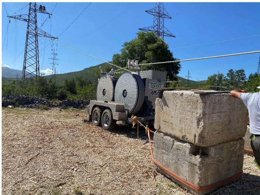
Slika 5.5. Stroj za razvlačenje vodiča, “kočnica”
