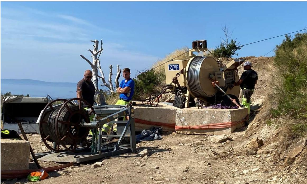
Slika 5.4. Stroj za razvlačenje vodiča, vučni stroj
