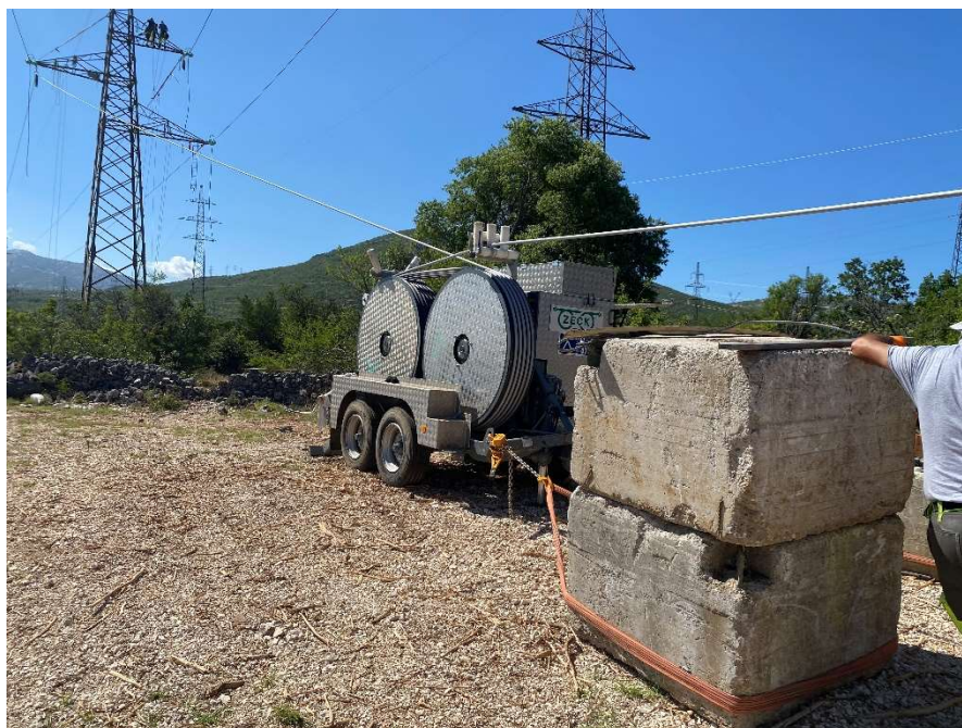
Slika 5.5. Stroj za razvlačenje vodiča, “kočnica”
