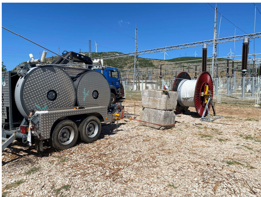
Slika 5.6. Stroj za razvlačenje vodiča, “kočnica” s bubnjem ACCC vodiča
