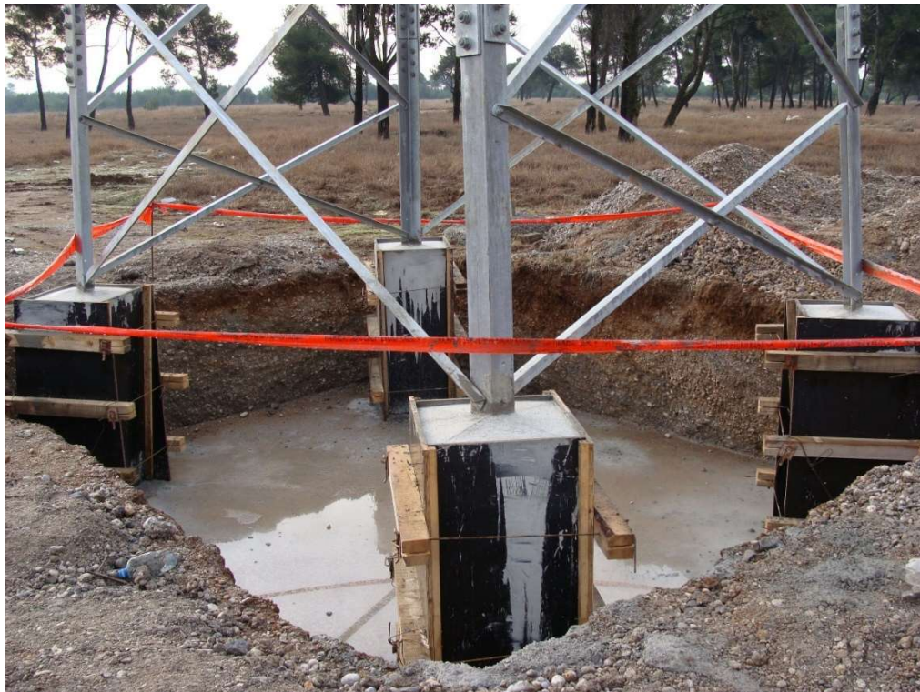
Slika 2.3. Temelj čelično-rešetkastog stupa
