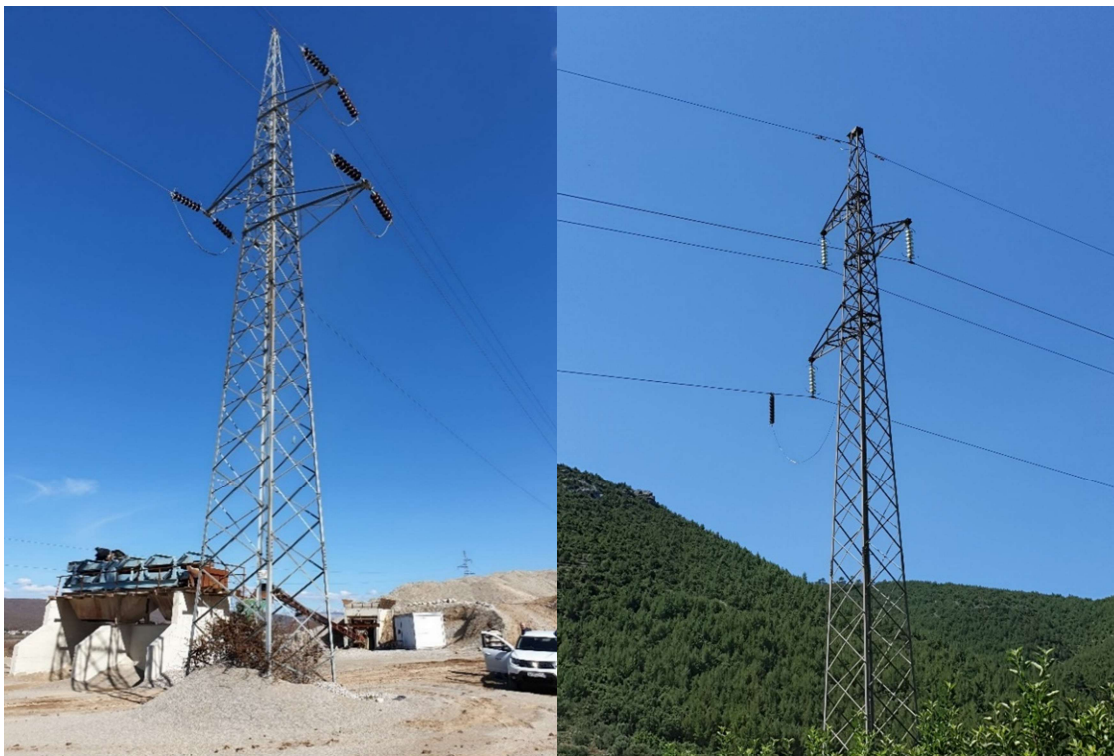
Slika 2.4. Zatezni i nosivi stup nadzemnog voda
