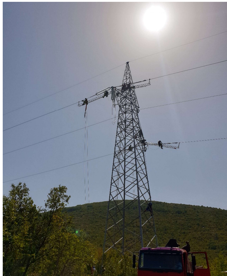
Slika 5.3. Armiranje zateznog stupa
