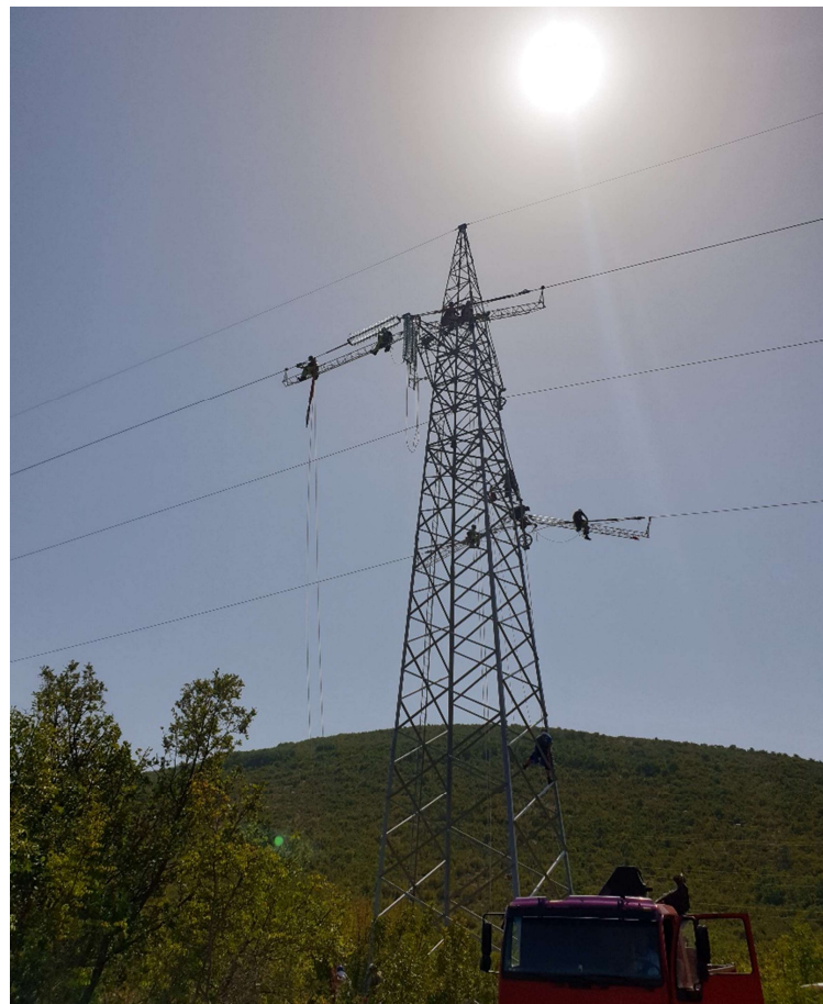
Slika 5.3. Armiranje zateznog stupa
