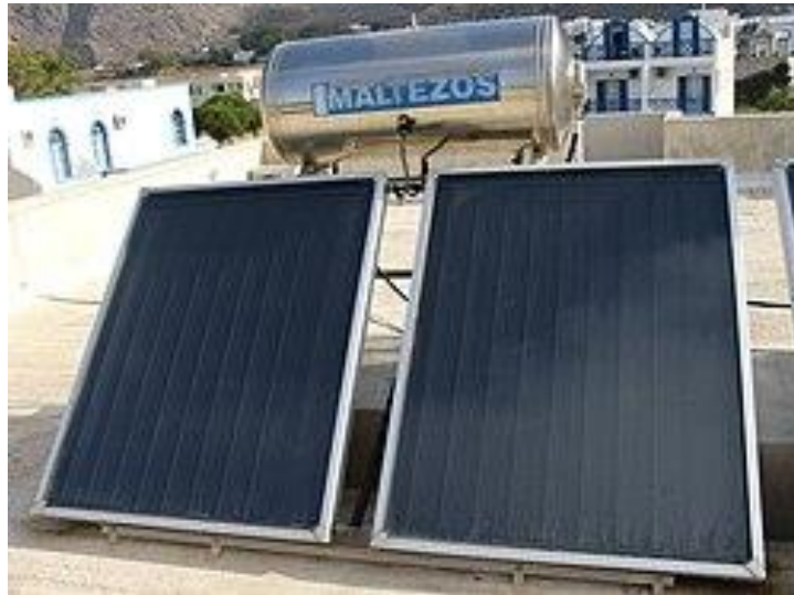
Slika 2.4. pločasti sunčev kolektor na ravnom krovu [2]
