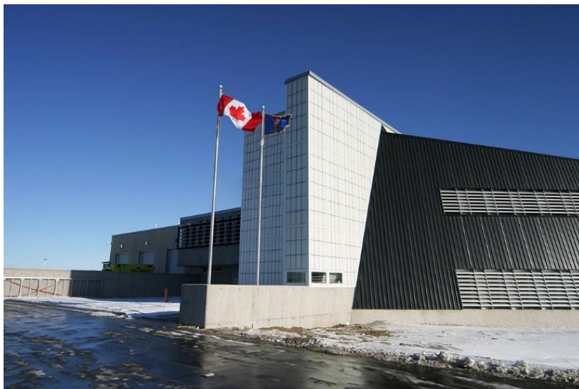
Slika 2.7. Fasada međunarodnog aerodroma u Torontu sa sunčevim zidom [5]
