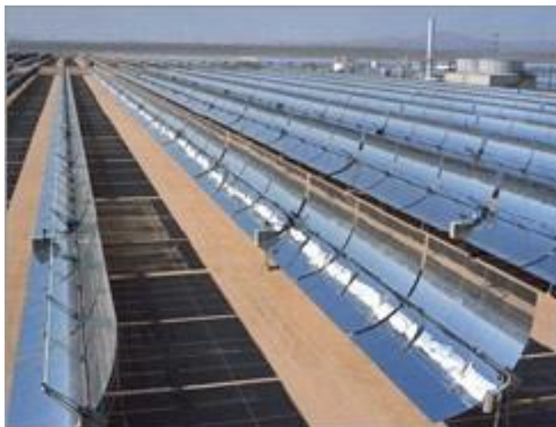
Slika 2.3. Parabolični kolektori [2]
