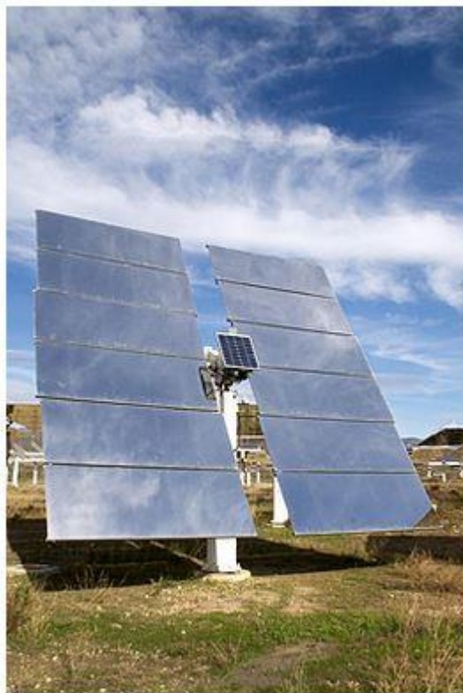
Slika 2.2 Heliostat u CRS postrojenju [5]
