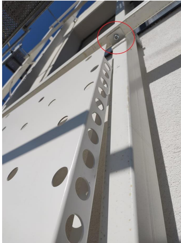
Slika 7.4 - Spoj vertikalnog i horizontalnog nosača
