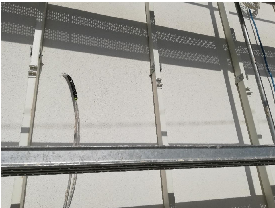
Slika 7.3 - Montirani vertikalni nosači
