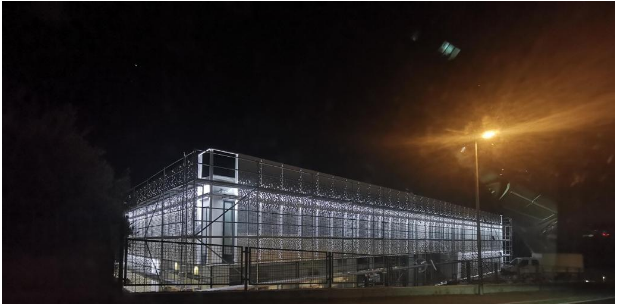
Slika 7.8 - Pogled na objekt sa osvijetljenom potkonstrukcijom noću #1
