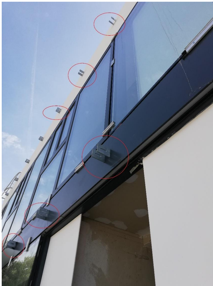
Slika 7.1 - Fasada objekta prije montaže potkonstrukcije
