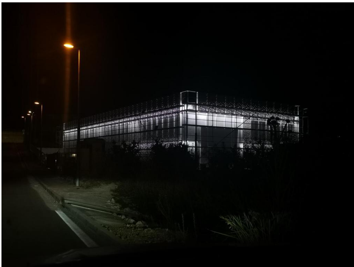
Slika 7.9 - Pogled na objekt sa osvijetljenom potkonstrukcijom noću #2
