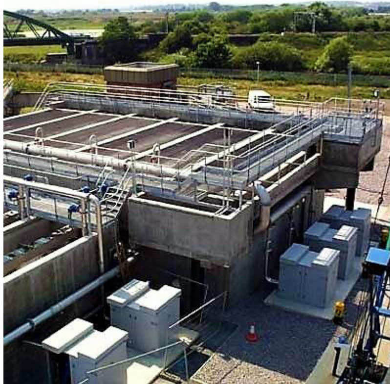
Slika 3.1 – Prikaz pogona za brzu pješčanu filtraciju [6]
