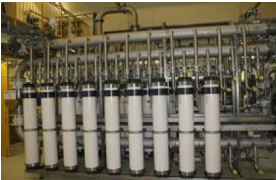
Slika 4.6 - Sustav za prečišćavanje vode pomoću tehnologije ultrafiltracije [10]
