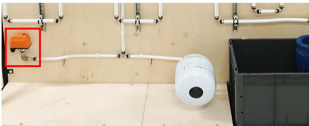
Slika 3.22 – Presostat (tlačna sklopka)
