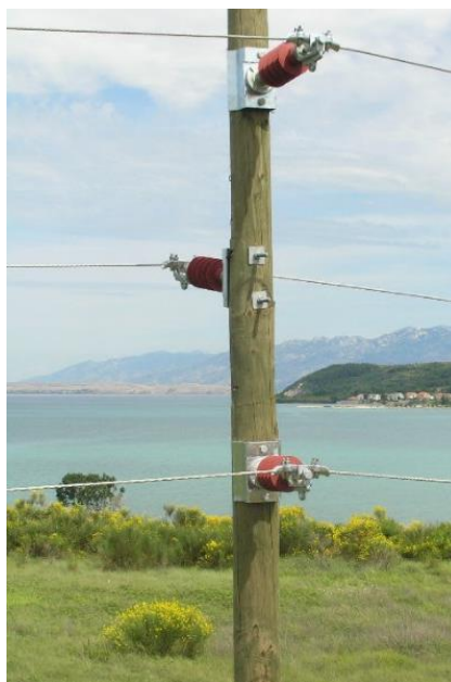
Slika 17. Horizontalni EVA izolator
