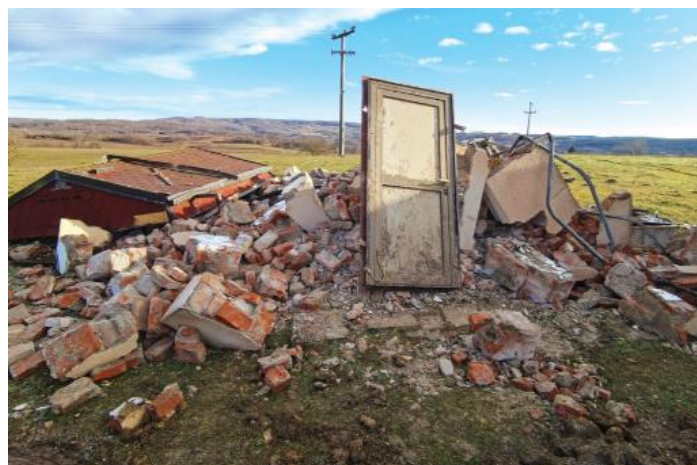
Slika 25. Ostatak TS Luščani
