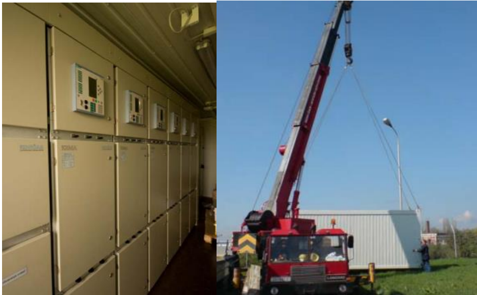
Slika 21. Istovar i unutrašnjost kontejnera sa SN opremom
