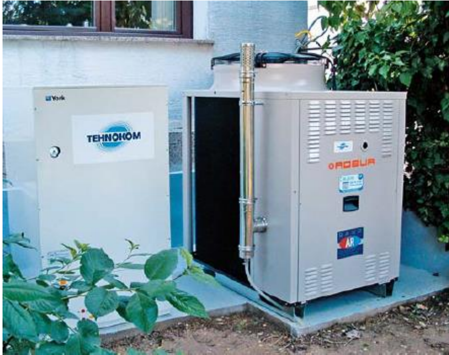
Slika 4.2 - Tehnokom-ova apsorpcijska plinska dizalica topline [8]
