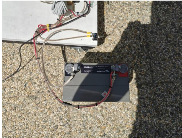
Slika 3.8 - Victron Energy AGM baterija 12V/60Ah
