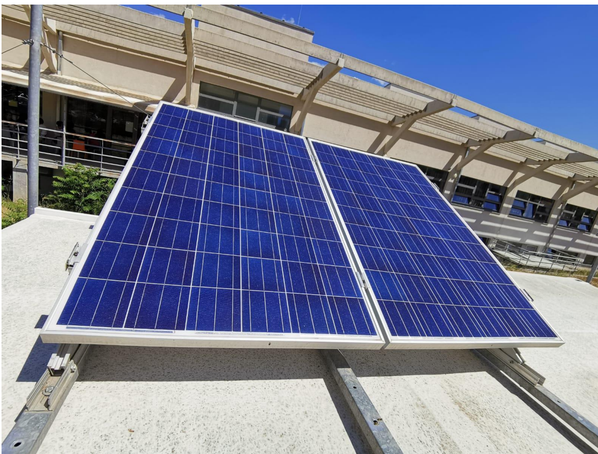
Slika 3.1 - Luxor LX 250P Polikristalni modul
