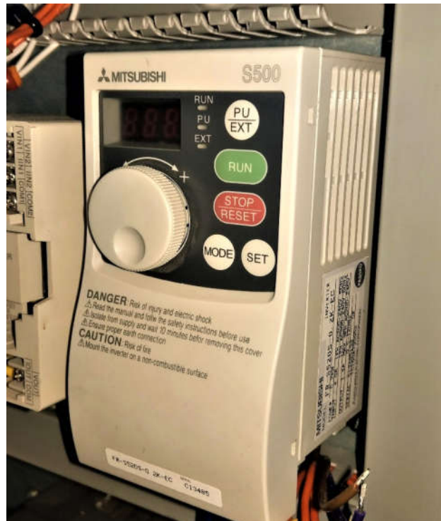
Slika 5.3. Frekvencijski pretvarač Mitsubishi S500 FR-S520S-0.2K
