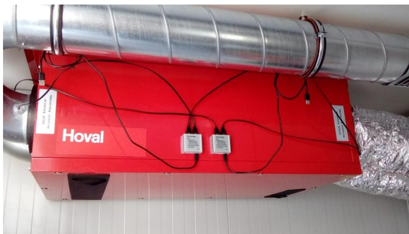
Slika 5.1 - SEK – SensorBridge spojen na osjetnike [13]
