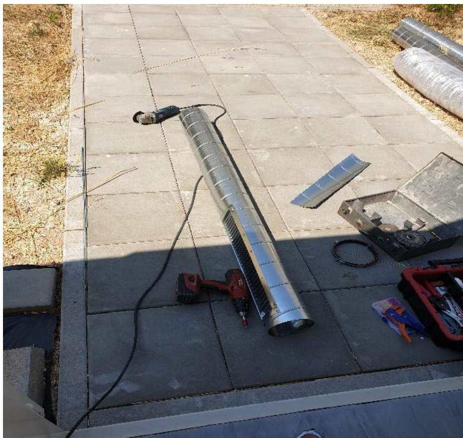
Slika 4.4 - Postavljanje rešetki na spiro kanal [13]
