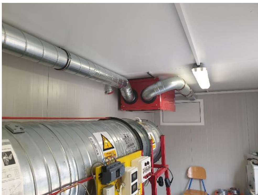
Slika 4.7 - Postavljen dovodni kanal [13]
