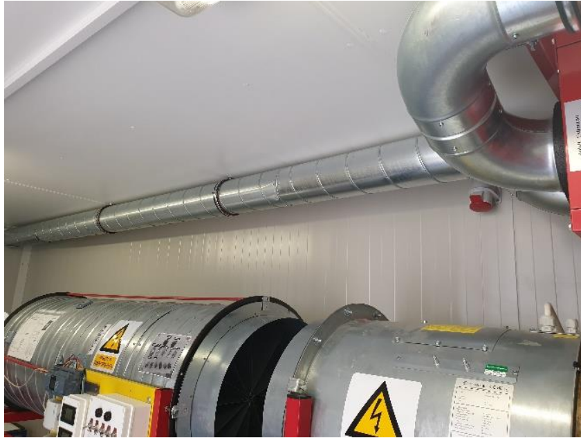
Slika 4.8 - Postavljen dovodni kanal [13]
