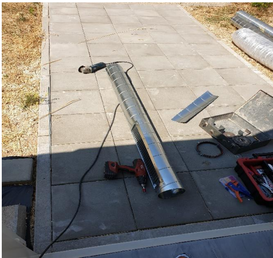
Slika 4.4 - Postavljanje rešetki na spiro kanal [13]
