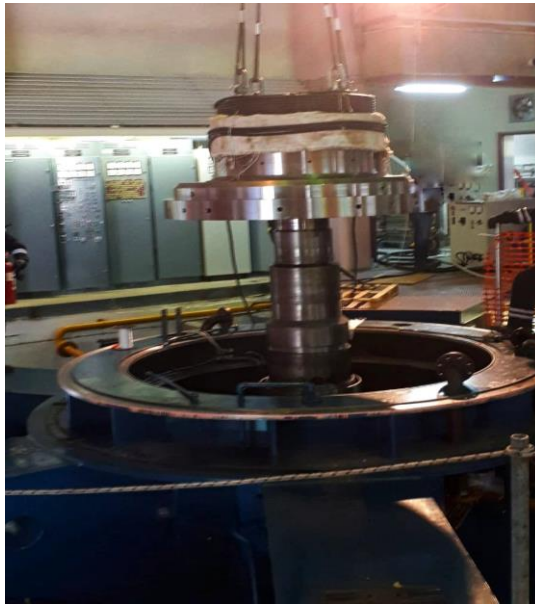
Slika 4. 6. Podizanje zvona generatora [15]
