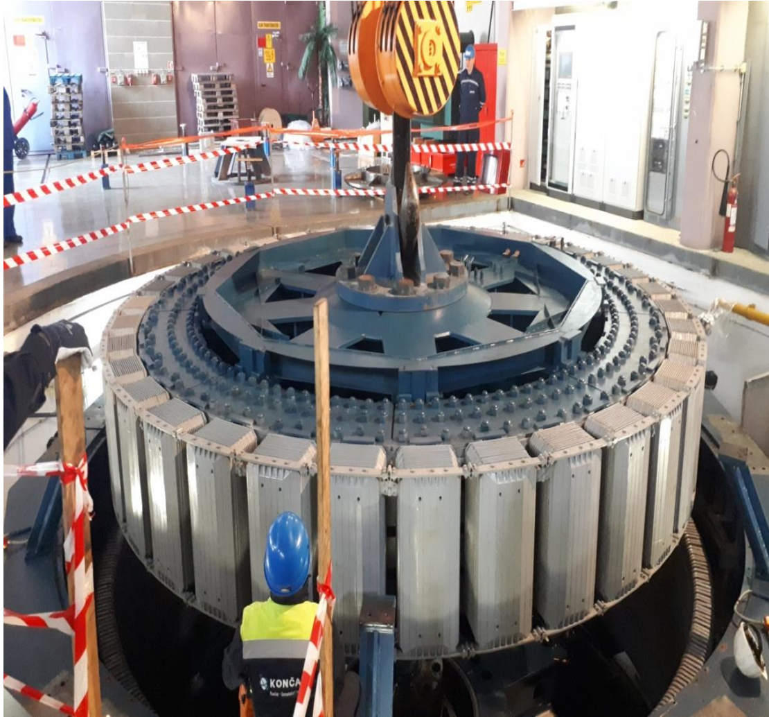
Slika 4. 14. Podizanje rotora [15]
