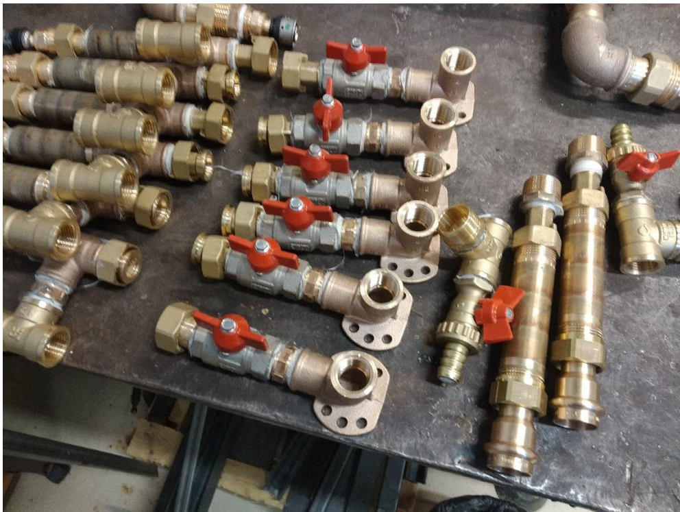
Slika 5.28 - Priprema sklopa prijelaza cjevovoda kroz ploču, spajanje elemenata
