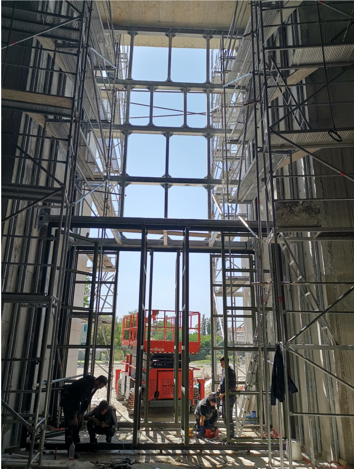
Slika 7.17 - Završena nosiva konstrukcija portala bazilike
