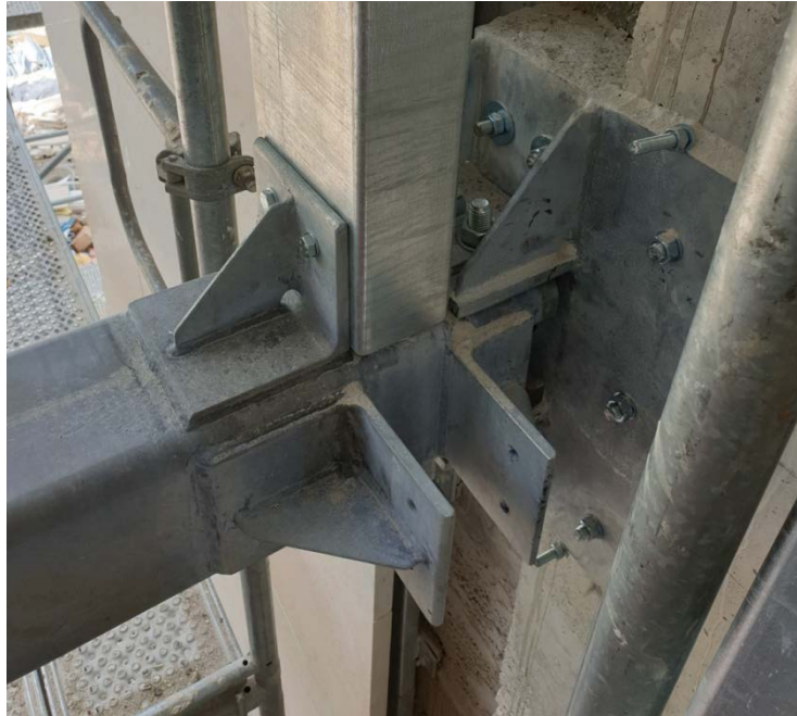
Slika 7.13 - Spoj vertikalnog i horizontalnog nosača
