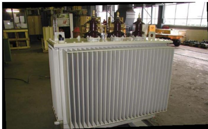
Slika 2. 5: VE ORLICE - transformator vlastite potrošnje (tzv. kućni transformator – KT)
