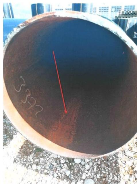
Slika 7.4 Površinski tragovi opće korozije unutar cijevi [44]
