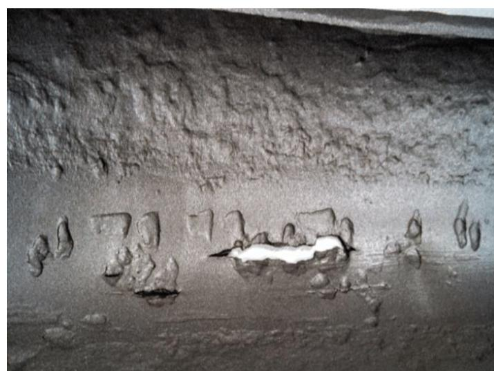
Slika 4.5 Primjer rupičaste korozije cjevovoda [12]
