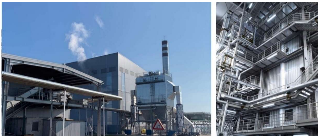
Slika 4.1. Kogeneracijsko postrojenje na drvnu biomasu "Energana Županja"
