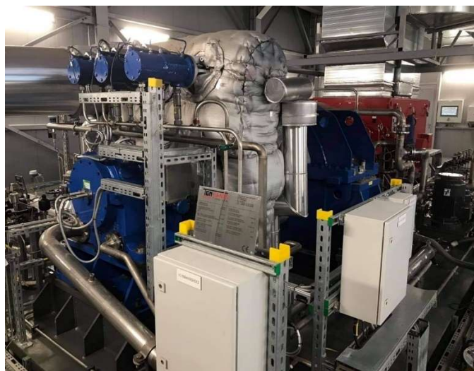
Slika 4.5. Parna turbina
