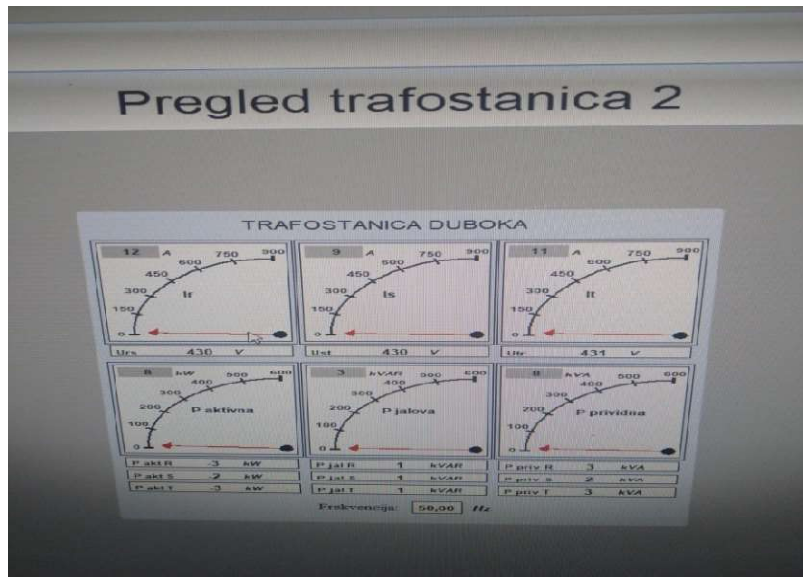
Slika 6.5. Nadzor TS Duboka u centru za nadzor i upravljanje Zaradeže [37]
