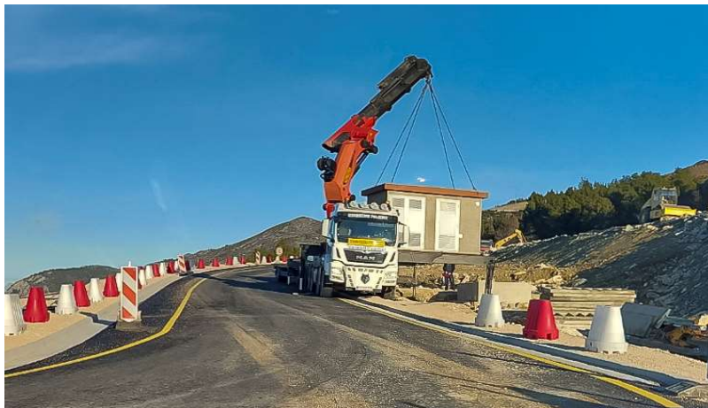
Slika 5.1. Montaža TS Duboka 10(20)/0,4 kV [37]
