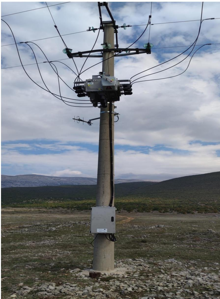
**Slika 10.** Stup srednjeg napona sa ugrađenom automatizacijskom opremom [TJ Sinj]
