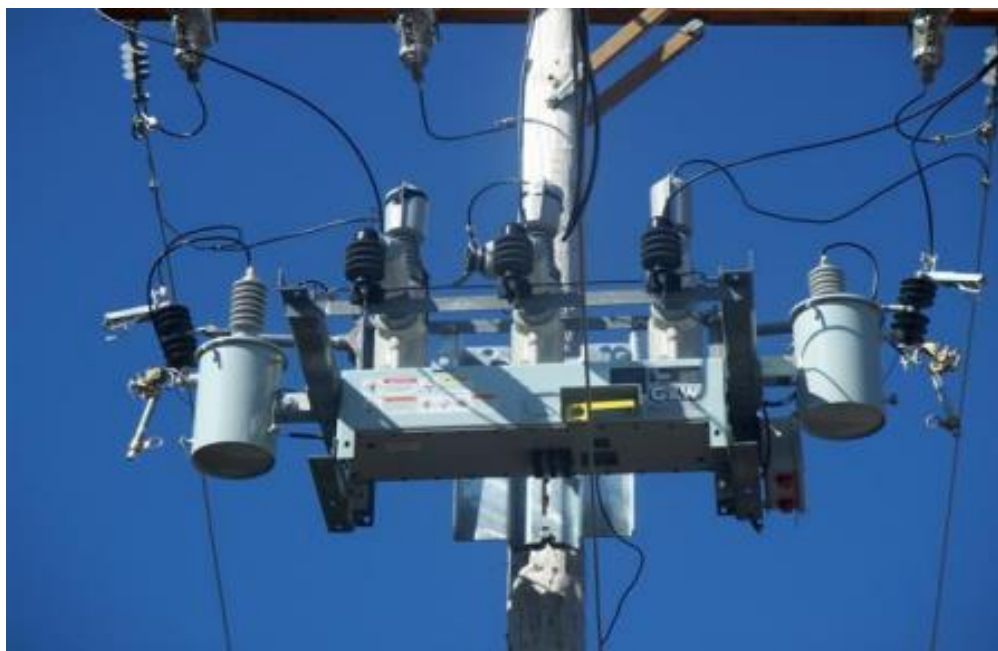
Slika 3.20. Automatski prekidač – recloser [8]
