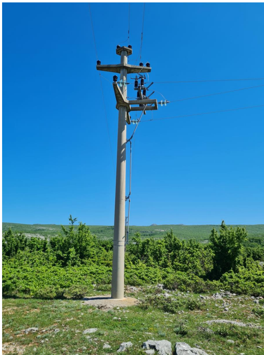
Slika 3.18. Stup bez ugrađenog DURN-a [TJ Sinj]
