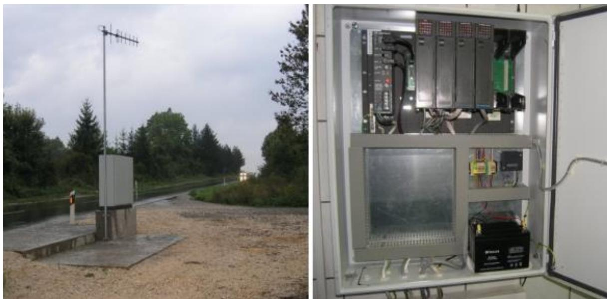
Slika 3.23. RTU ormar i oprema unutar ormara [9]
