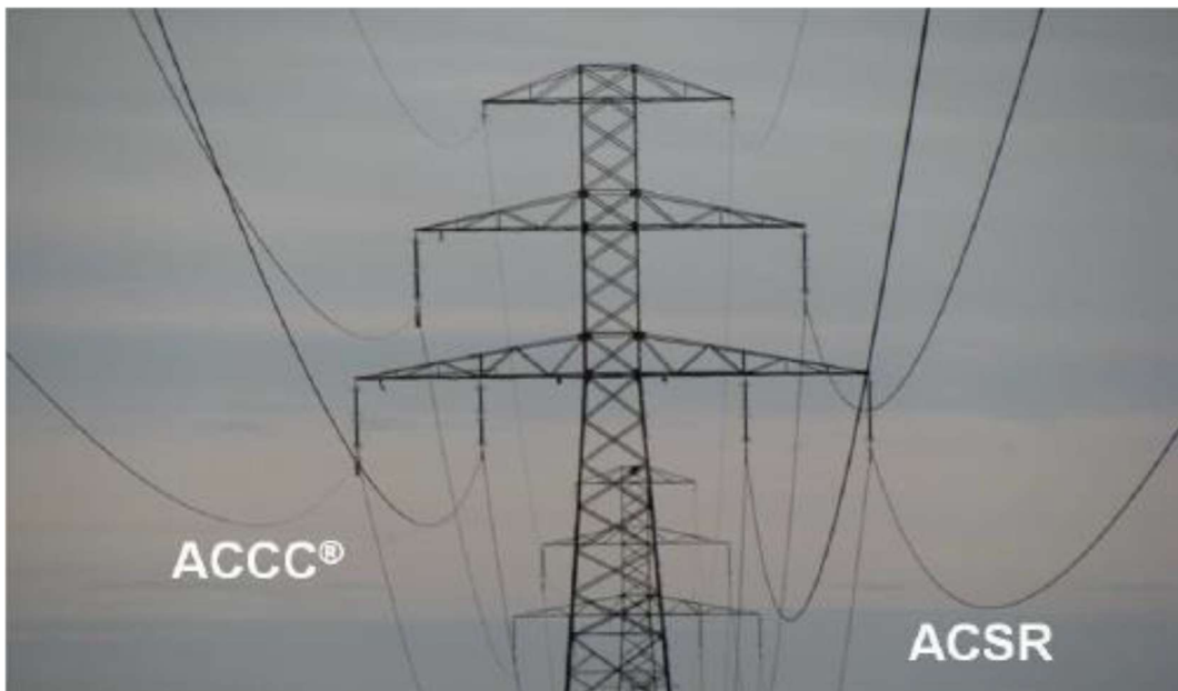
Slika 4.1. Prikaz razlike u provjesu ACCC i klasičnog ACSR vodiča [9]
