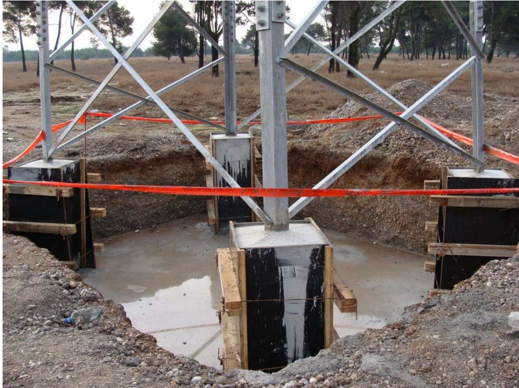
Slika 2.3. Temelj čelično-rešetkastog stupa
