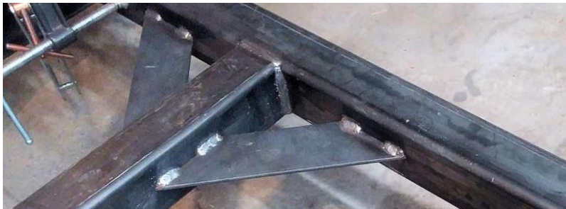
Slika 2.8 – Zavarene ukrute u blizini sjecišta poprečnog i uzdužnog nosača prikolice [17].
