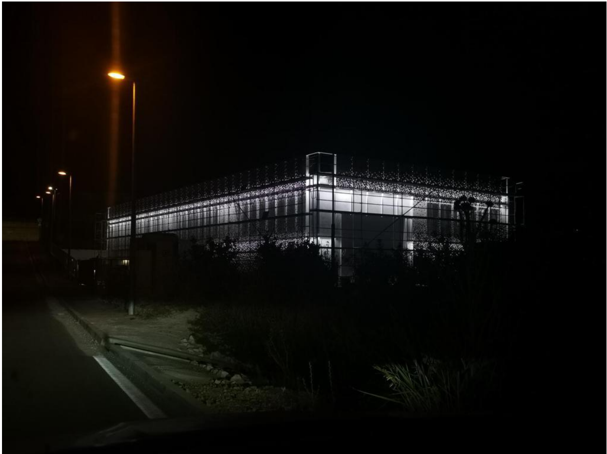
Slika 7.9 - Pogled na objekt sa osvijetljenom potkonstrukcijom noću #2
