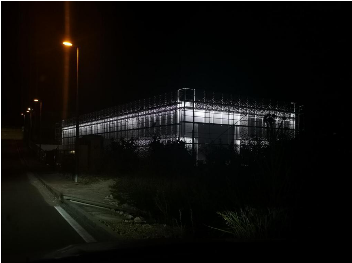
Slika 7.9 - Pogled na objekt sa osvijetljenom potkonstrukcijom noću #2
