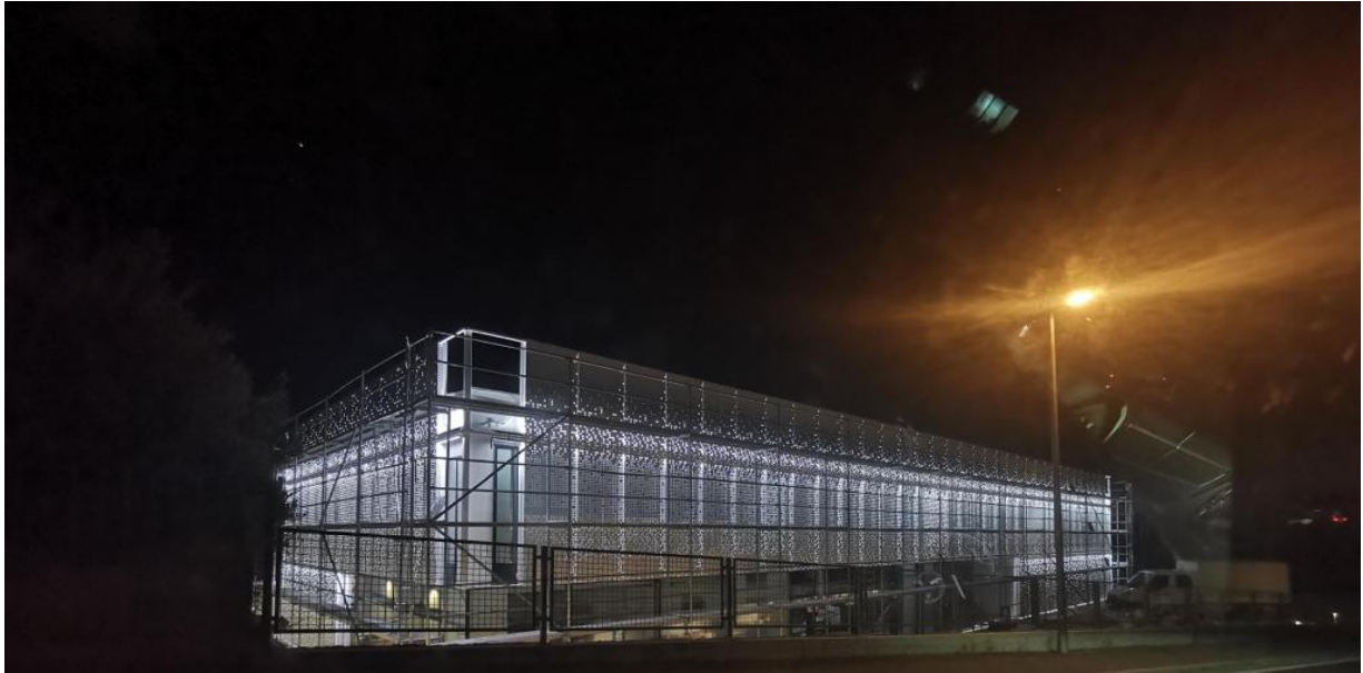
Slika 7.8 - Pogled na objekt sa osvijetljenom potkonstrukcijom noću #1
