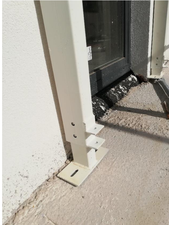
Slika 7.2 - Vertikalni nosač postavljen na temeljnom nosaču
