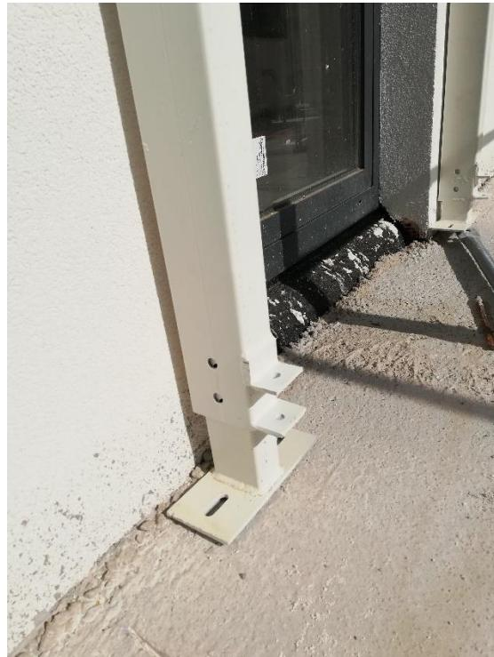
*Slika 7.2 - Vertikalni nosač postavljen na temeljnog nosaču*
