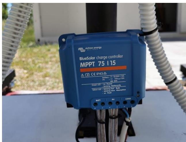
Slika 3.10 - Solarni regulator punjenja
