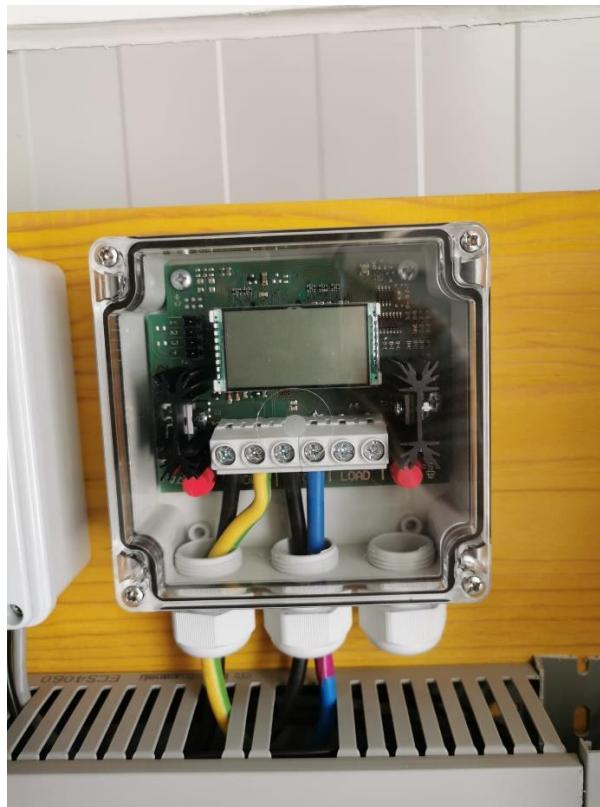
Slika 3.19 - STECA PR 2020 IP65
