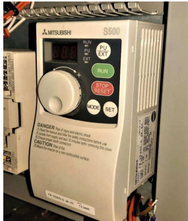
Slika 5.3. Frekvencijski pretvarač Mitsubishi S500 FR-S520S-0.2K
