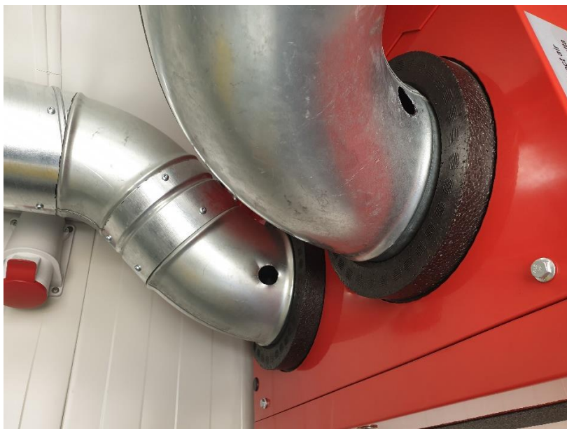
Slika 4.15 - Izbušeni otvori za osjetnike [13]
