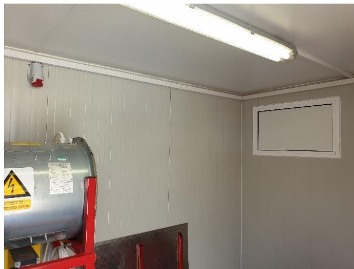
Slika 4.1 - Strop kontejnera prije montaže [13]
