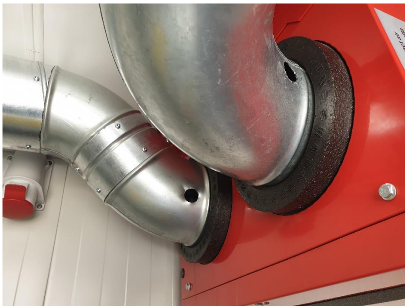
Slika 4.15 - Izbušeni otvori za osjetnike [13]
