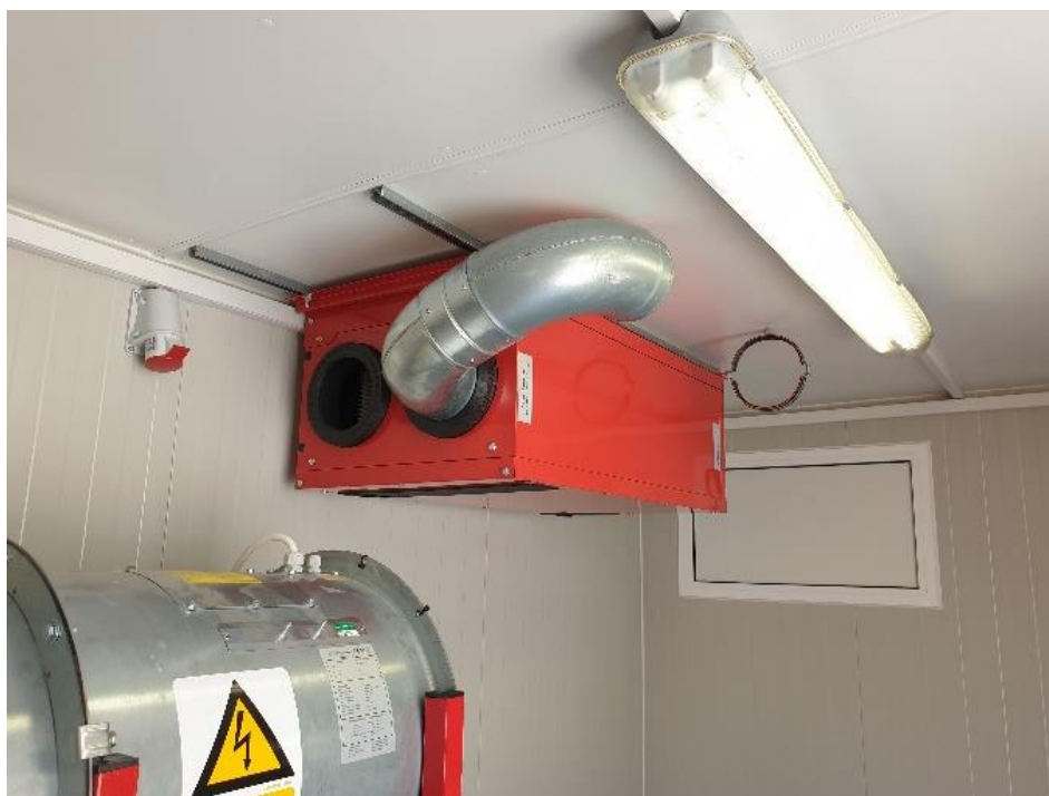
Slika 4.5 - Postavljanje nosača kanala [13]
