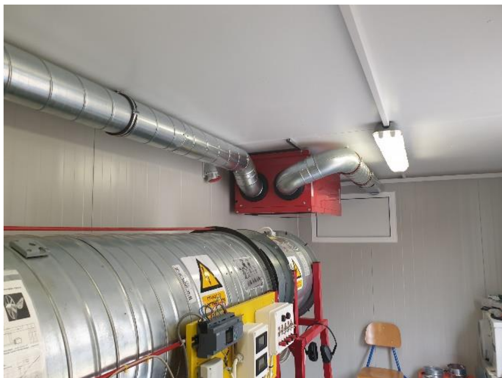
Slika 4.7 - Postavljen dovodni kanal [13]
