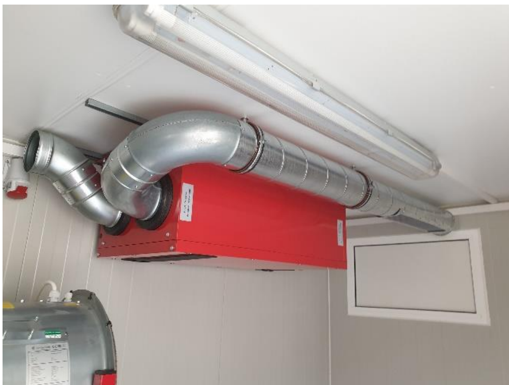
Slika 4.6 - Postavljen odvodni kanal [13]
