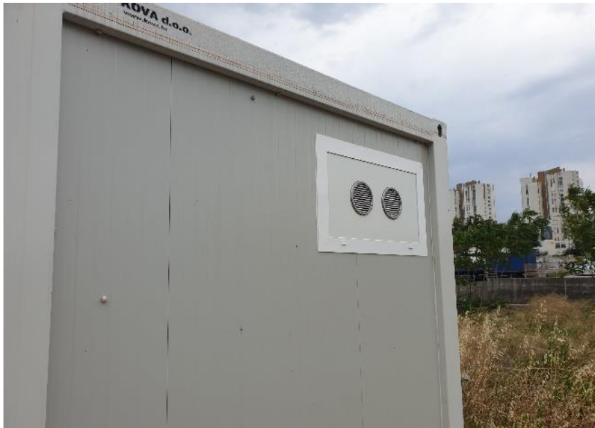
Slika 4.12 - Protu-kišne rešetke NVM 150 izvana [13]
