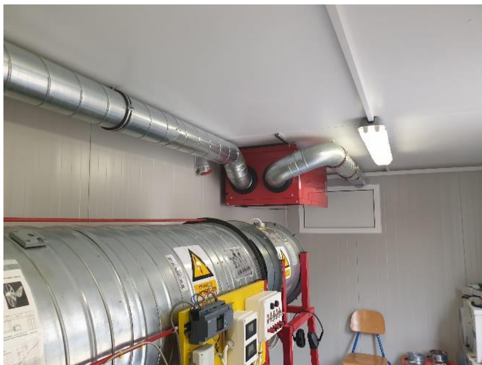
Slika 4.7 - Postavljen dovodni kanal [13]
